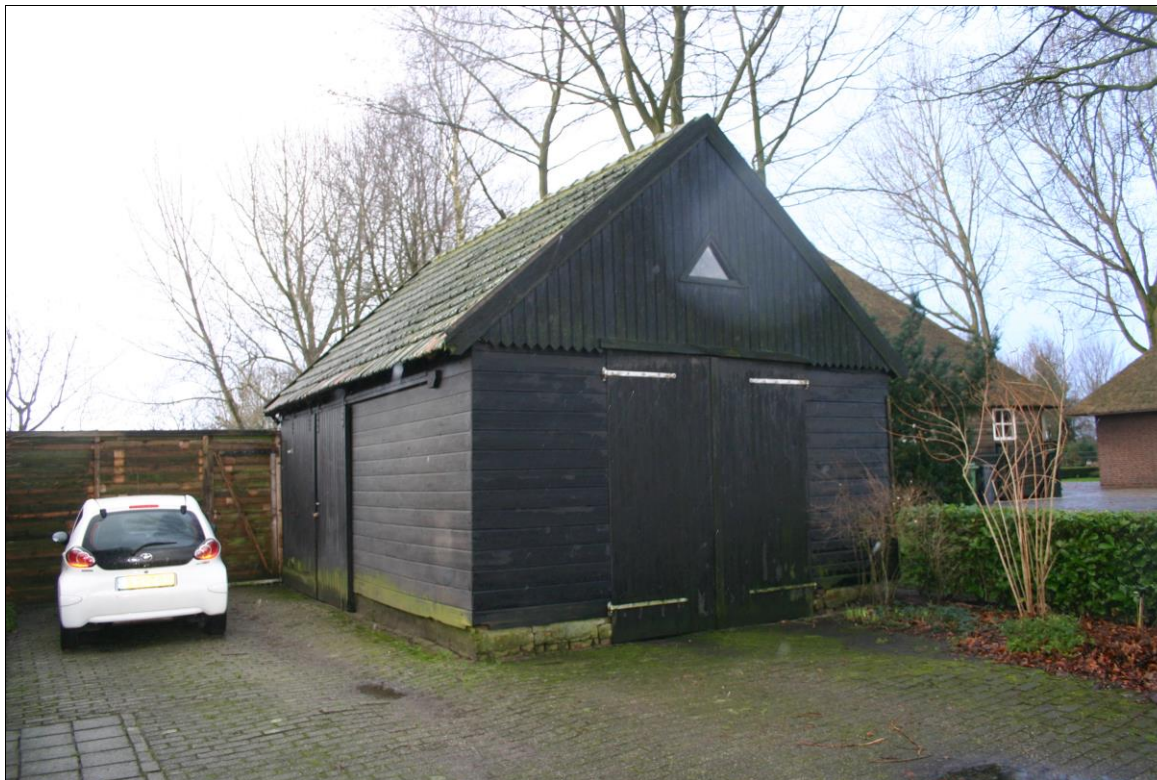
Figuur 3. De houten schuur (huisnummer 34).
