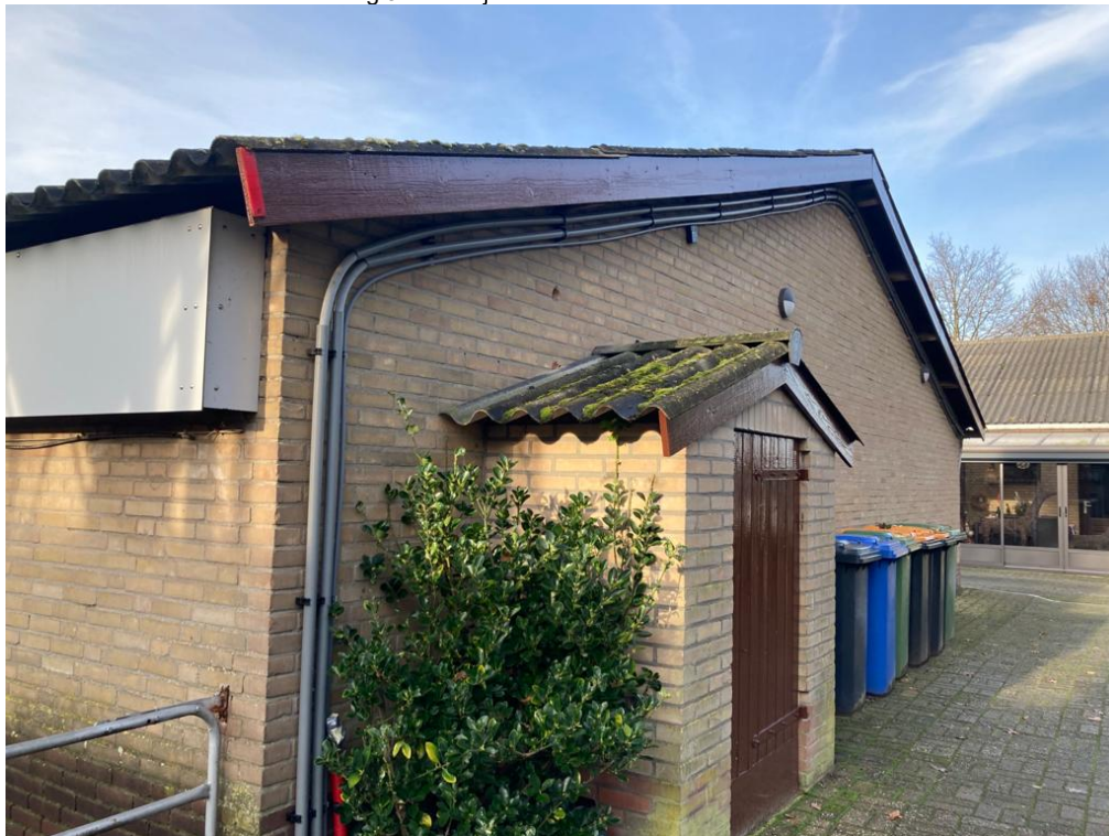
• Afbeelding 5: buitenzijde stallen
