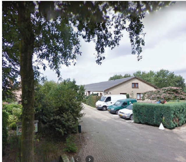
Beeld 3. Inrit en parkeren bij bedrijfsgebouw (bron: Google.com)
