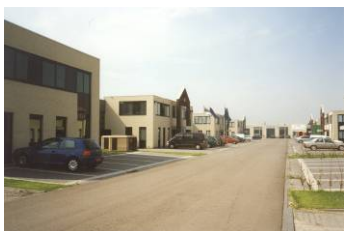
Foto: Concentratie van kleinschalige bedrijfspanden aan de
