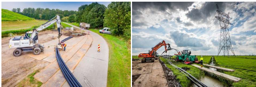
Afbeelding 3.5 Impressies boring met uitleg mantelbuizen
