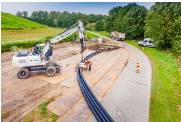
Figuur 22 Impressie boring met uitleg mantelbuizen
