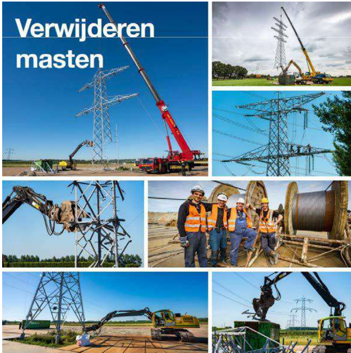
Figuur 2.12. Verwijderen bestaande masten (bron: TenneT)
