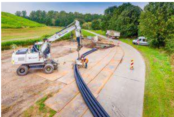
Figuur 3 Impressie boring met uitleg mantelbuizen
