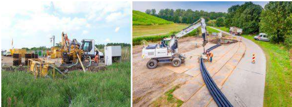
Figuur 2.11 Impressie werkterrein boring (bron: TenneT)
