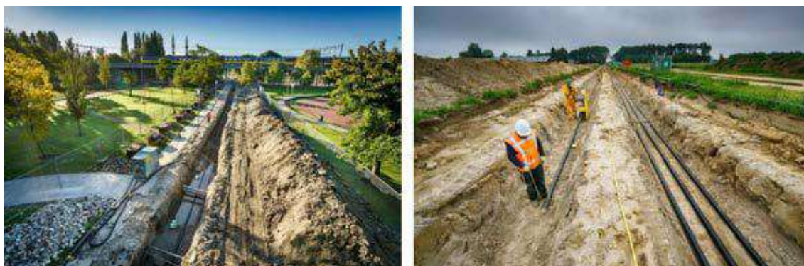
Figuur 2.9 Impressie werkstrook open ontgraving (bron: TenneT)
