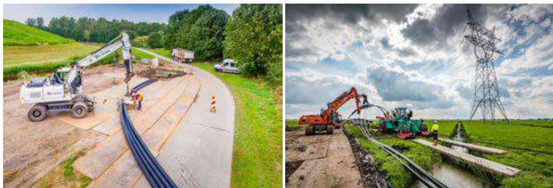
Afbeelding 3.5 Impressies boring met uitleg mantelbuizen
