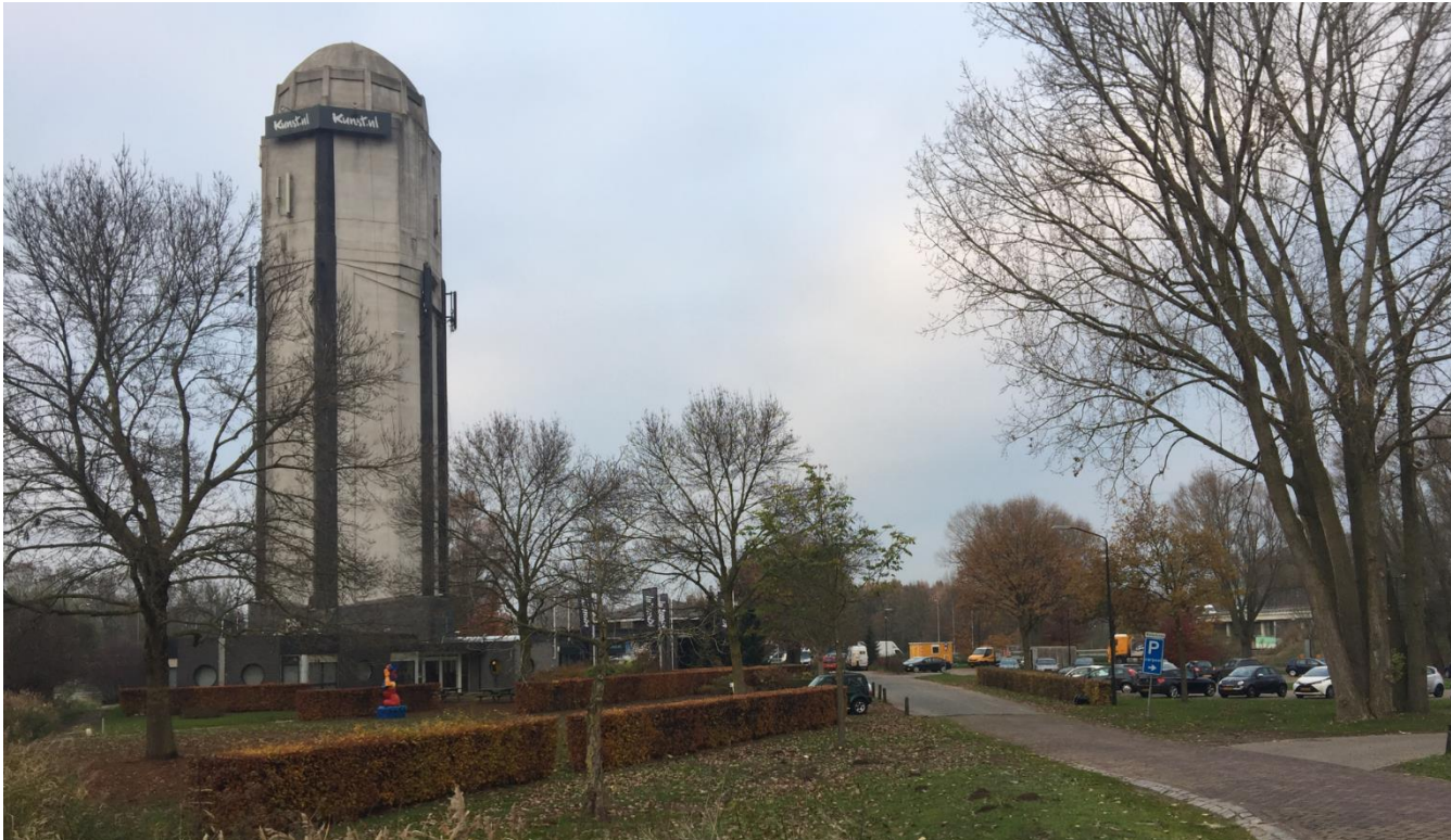
Figuur 4: Overzicht plangebied met watertoren, bijbehorende gebouwen en parkeerplaats
