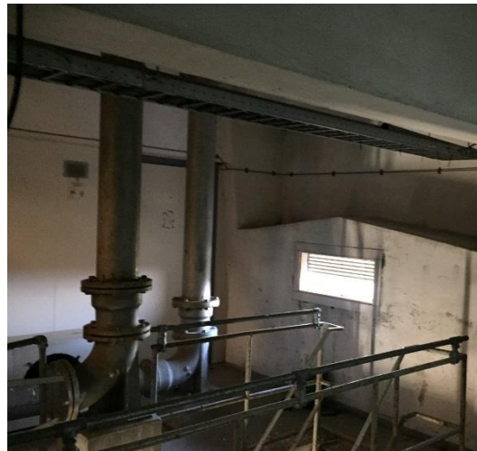
IJzeren leidingen en de oorspronkelijke stalen trap met leuningen op de verdieping vlak onder het reservoir. Het venster is een latere toevoeging.
