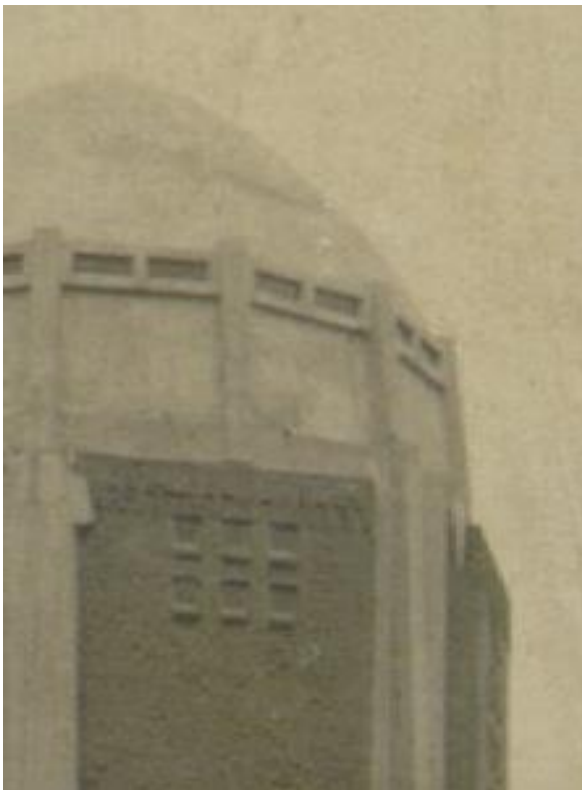
Beide zijaanzichten van de watertoren. Het venster in de rondgang bij het reservoir (oostzijde), is een latere toevoeging. Op de oude foto is de oorspronkelijke situatie te zien (zijaanzicht).
