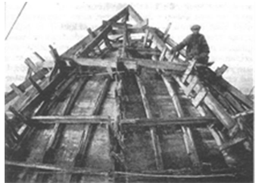
1925 – de constructie van de bekisting van de koepel van de watertoren in Raamsdonksveer (De Ingenieur 43 (1928, no 4) p. 40).
