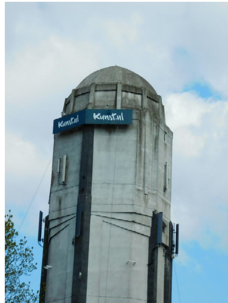
Figuur 12 - De detaillering van de watertoren vertoont typische kenmerken van de Art Deco.
