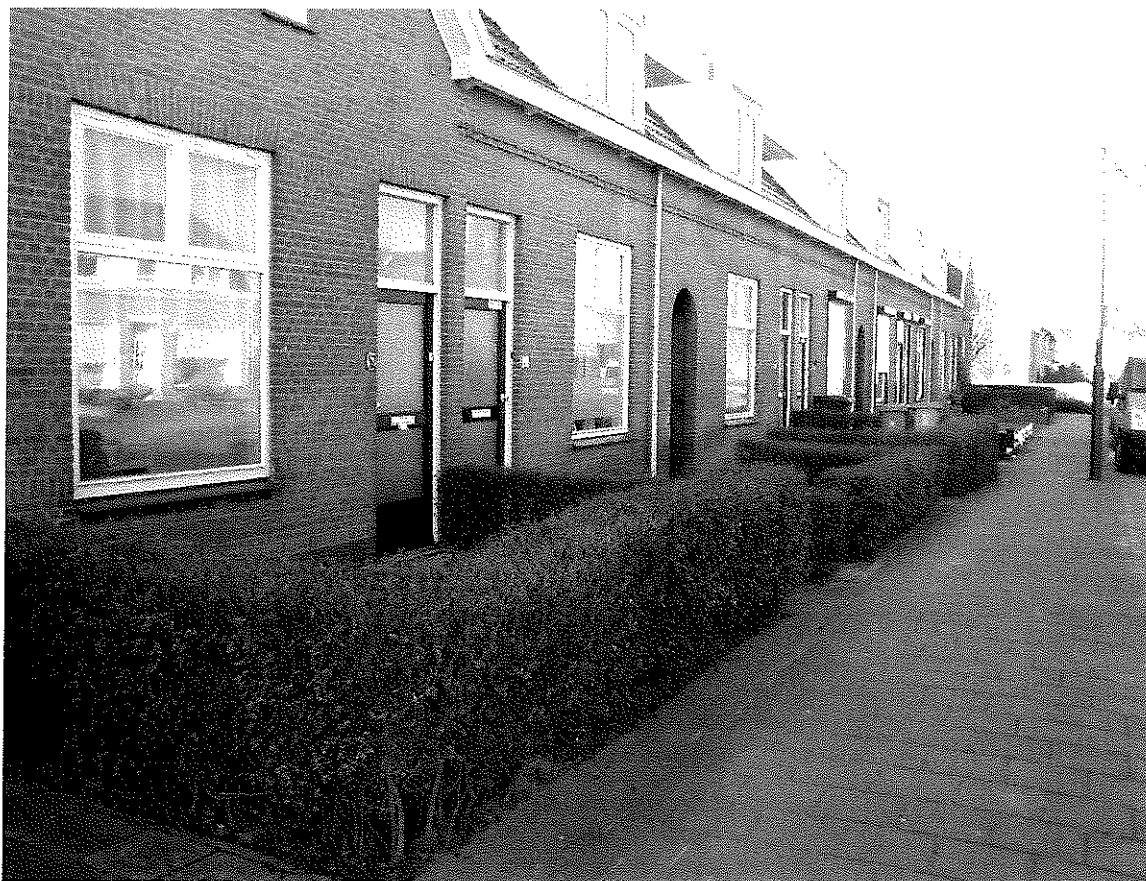
Foto 3: aanzicht locatie in noordoostelijke richting
