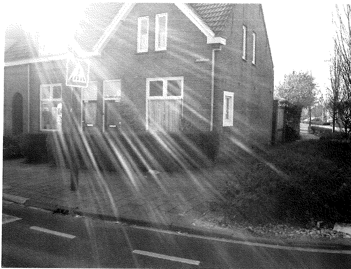
Foto 1: aanzicht locatie in zuidelijke richting
