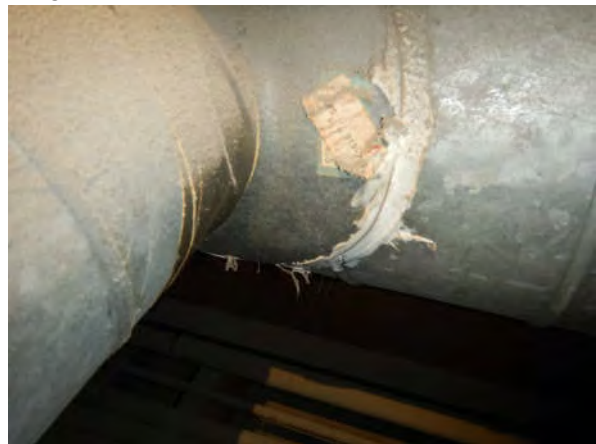
De kit bij de luchtbehandeling is van siliconen en niet verdacht
