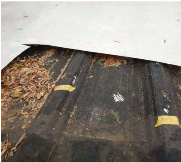
Bron 5, M07 en M08 bitumen dak (1)
