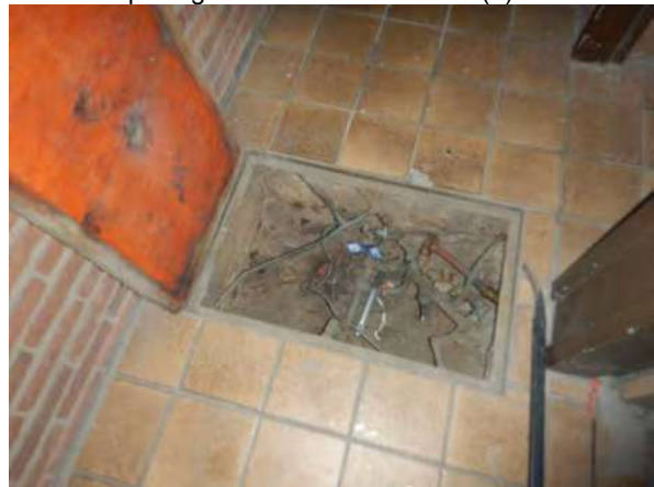
Watermeterput, geen kruipruimtes aangetroffen
