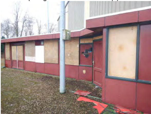
Volkernbeplating met hout, niet verdacht
