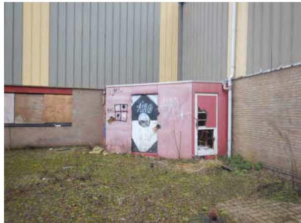
Volkernbeplating met hout niet verdacht (2)
