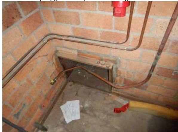
Houten ventilatiekanalen in de gevel
