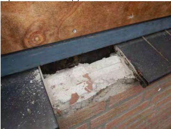
In de spouw geen verdachte materialen aangetroffen
