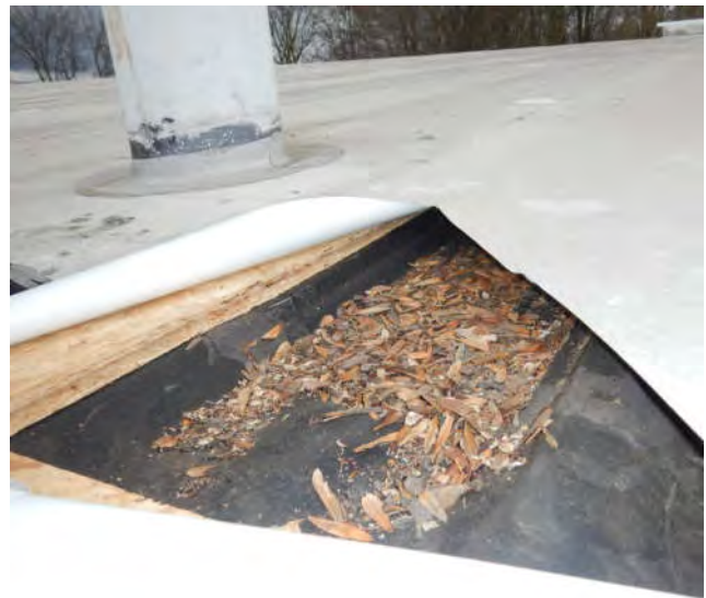
Bron 5, M07 en M08 bitumen dak (2)
