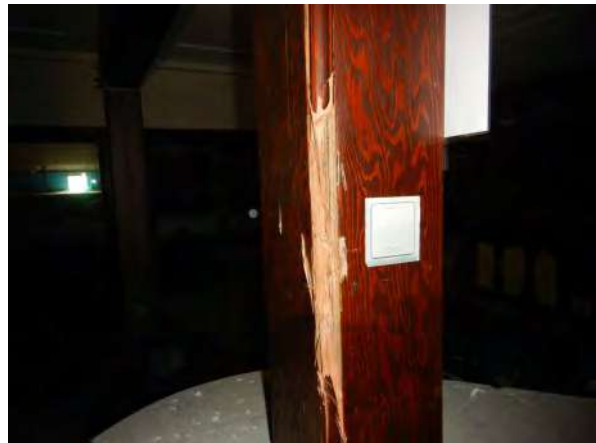
Hout om stalen constructie
