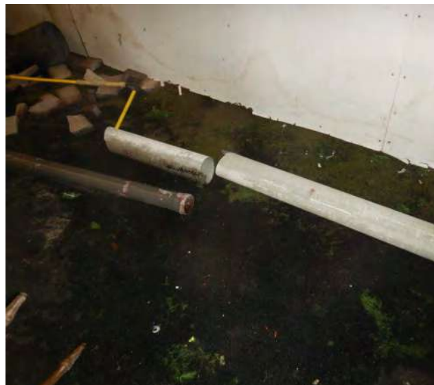
Bron 2, M02 buizen (1)
