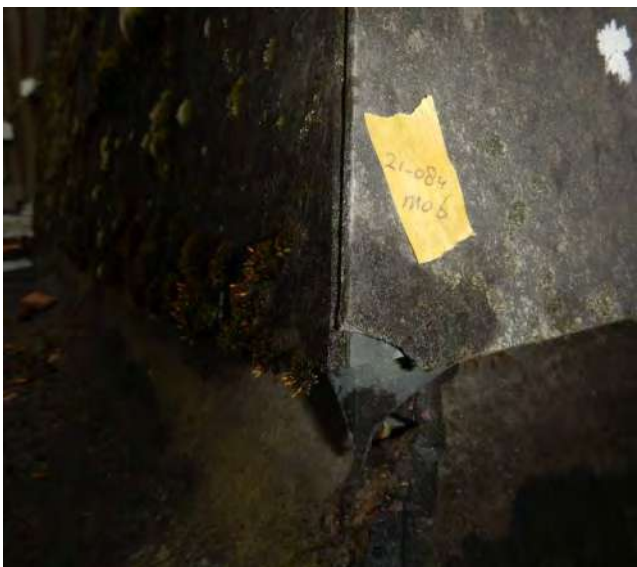
Bron 4, M06 dakleien (1)
