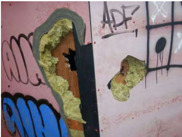
Volkernbeplating met hout niet verdacht (1)
