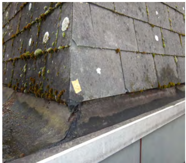
Bron 4, M06 dakleien (2)
