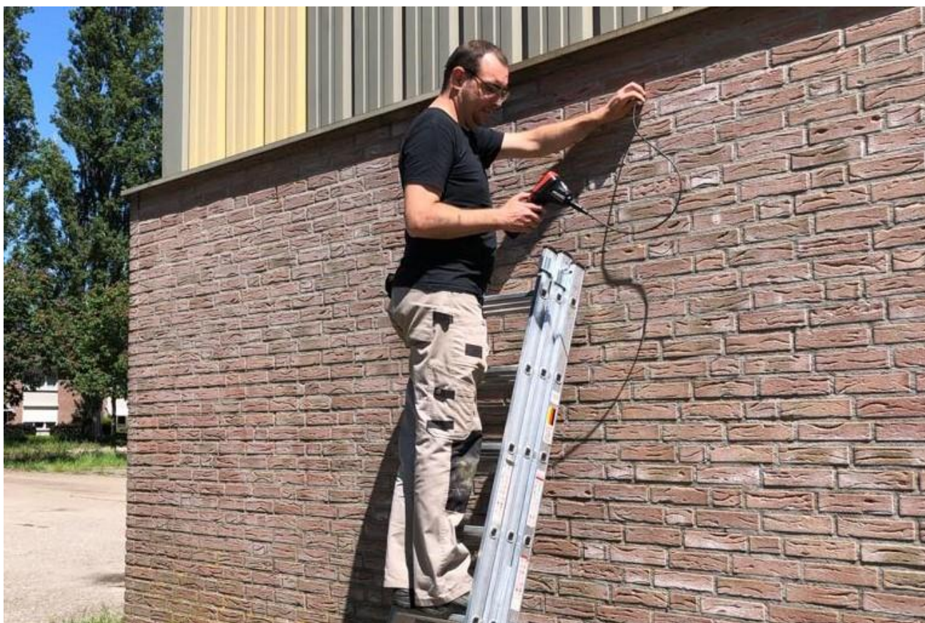
Figuur 1 Endoscooponderzoek. Alle stootvoegen en andere openingen in de onderste bouwlaag zijn onderzocht met behulp van een endoscoopcamera.
