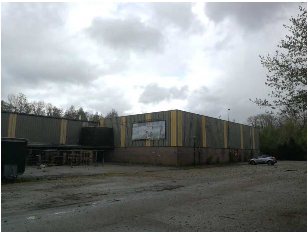
Figuur 2 De sporthal gezien aan de zuidwestzijde.
