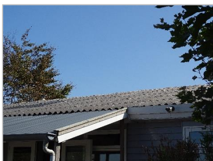
Foto 23: Dak van restaurant 'Smaakwater'.
