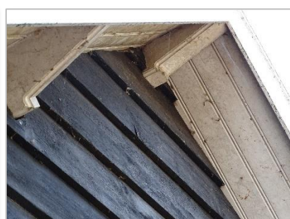
Foto 4: Detail schuur bij woning.
