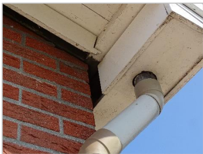
Foto 26: Dak van restaurant 'Smaakwater'.
