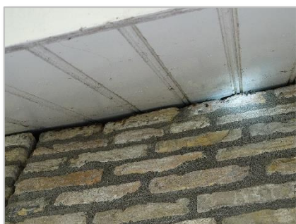
Foto 14: Kieren bij dakrand woning.
