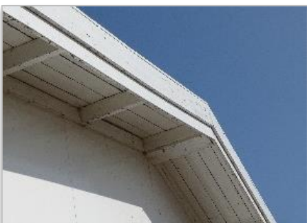
Foto 24: Dak van restaurant 'Smaakwater'.
