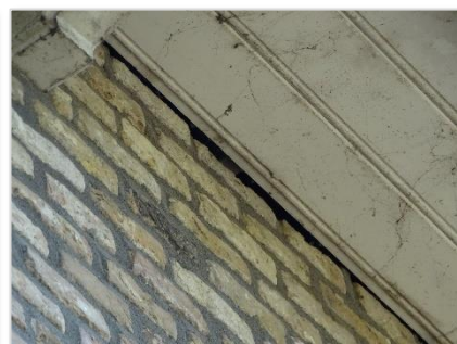
Foto 13: Kieren bij dakrand woning.
