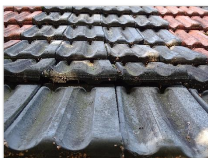
Foto 21: Dak van schuur bij woning.
