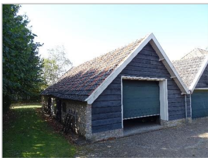
Foto 2: Schuur bij woning.
