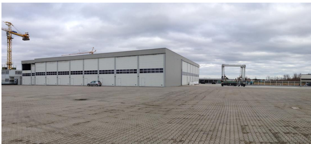
bestaande winterstalling en botenlift
