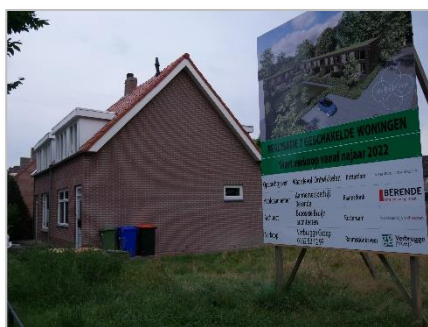
Compleet gerenoveerde woning aanliggend perceel Foto 40
