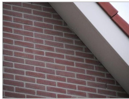
Gerenoveerde dakrand Foto 41
