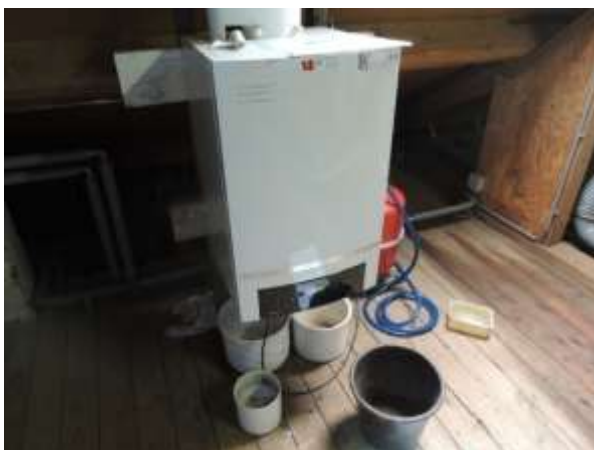
Foto 3: In de woning is een CV-ketel aangetroffen van het merk Nefit type opline uit het bouwjaar 2013.
