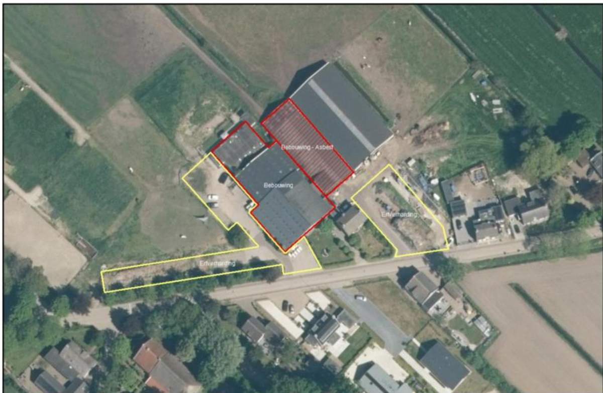
Afbeelding 12: Te slopen bebouwing
