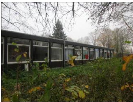
Foto 1: Bebouwing binnen het plangebied
