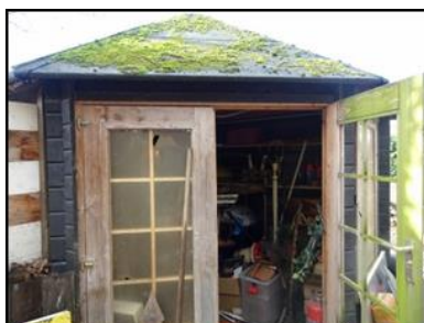
Figuur 7. Schuur 2, gelegen in het zuidelijke deel van de onderzoekslocatie.
