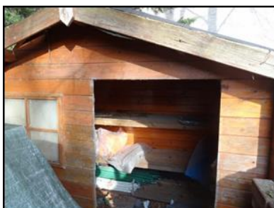
Figuur 6. Schuur 4, gelegen in het noordelijke deel van de onderzoekslocatie.
