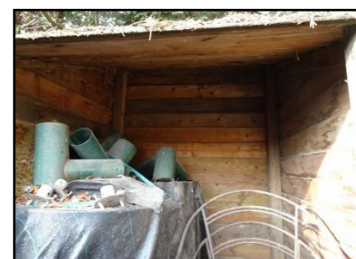
Figuur 8. Schuur 3, gelegen in het noordelijke deel van de onderzoekslocatie.
