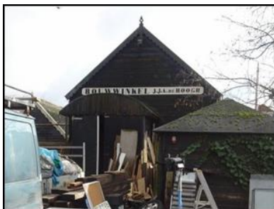
Figuur 3. Schuur 1, gelegen in het zuidelijke deel van de onderzoekslocatie.
