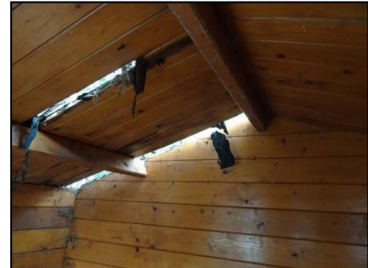
Figuur 12. Binnenkant van schuur 4 in het noordelijke deel van de onderzoekslocatie.
