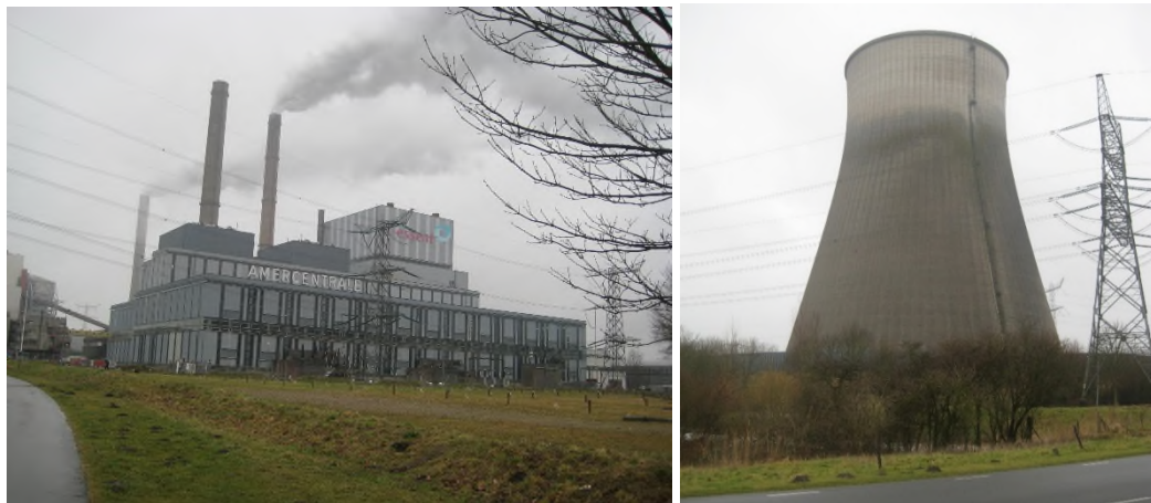
Figuren 2.4 en 2.5: Amercentrale - Amerweg 1 - Geertruidenberg
