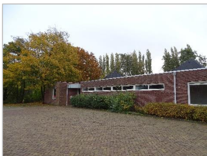
Foto 2: Impressie plangebied (schoolgebouw).
