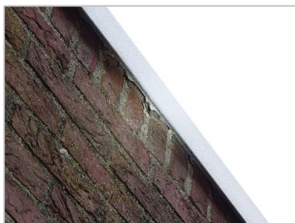
Foto 23: Openingen bij dakrand.
