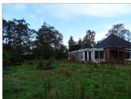
Foto 5: Impressie plangebied (verruigd schoolplein).
