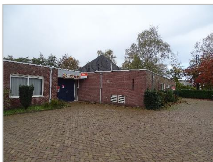
Foto 3: Impressie plangebied (schoolgebouw).
