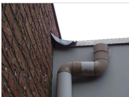
Foto 21: Openingen bij dakrand.
