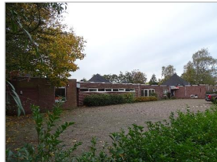
Foto 4: Impressie plangebied (schoolgebouw).
