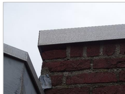
Foto 22: Openingen bij dakrand.
