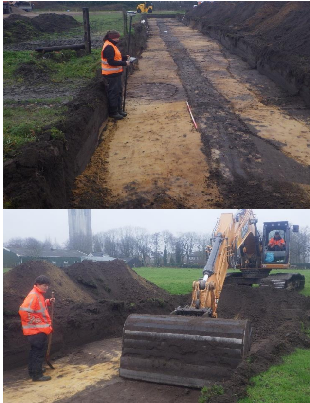
Afb. 4. Een impressie van het veldwerk. Boven: inmeten van het vlak in werkput 1 met de GPS. Onder: de aanleg van het vlak in werkput 3.
