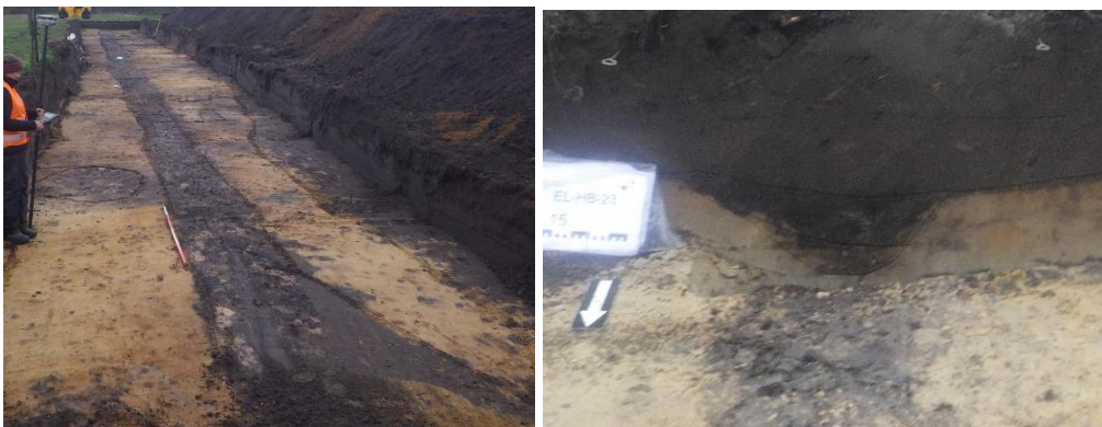
Afb. 10. De greppel op het vlak in proefsleuf 1 en de coupe over de greppel in proefsleuf 5.
