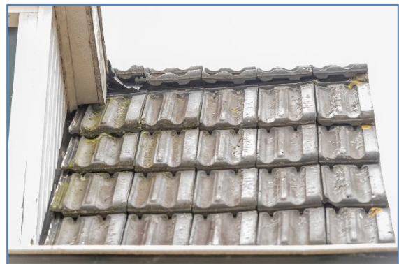
Figuur 04: gevelbetimmeringen, opstaande loodflappen en dakpannen.
