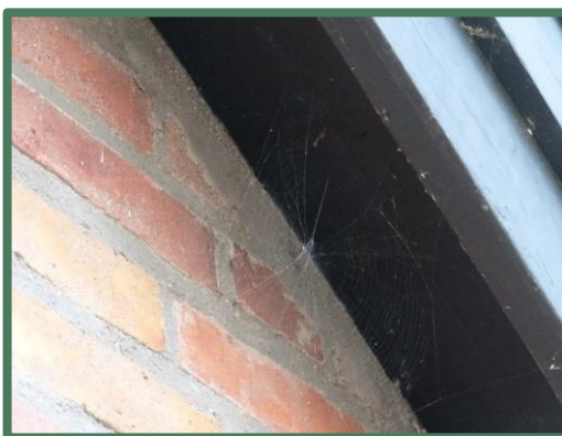
ruimte tussen de muren en het dakbeschot dichtgesmeerd
