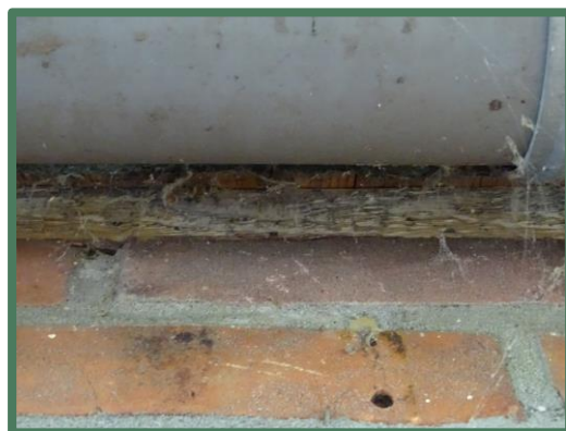
Panlat tussen de muren en goot
