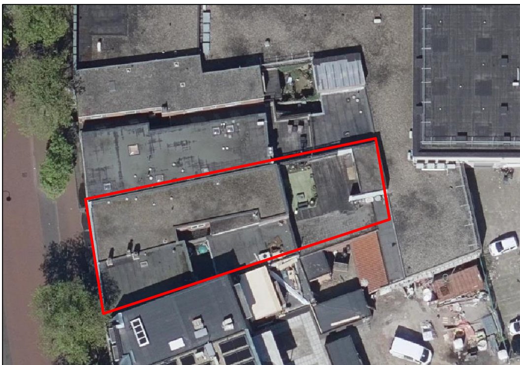
Figuur 22: Huidige bebouwing/verharding binnen plandeel Bisschopsmolenstraat 45 en 47 (planlocatie is indicatief voorzien van een rode omlijning)
