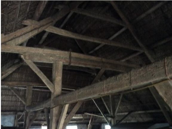
Figuur 4 | hoofddraagconstructie
