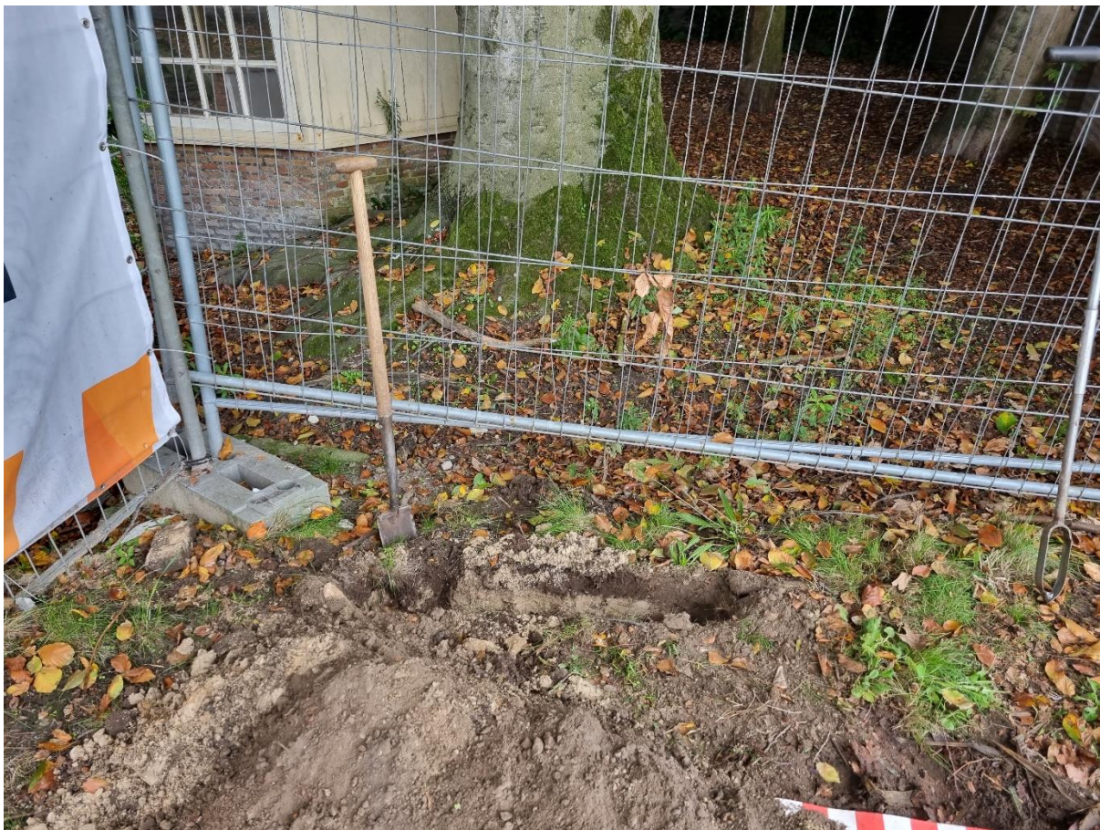
Foto 29: proefsleuf nabij boom 22
