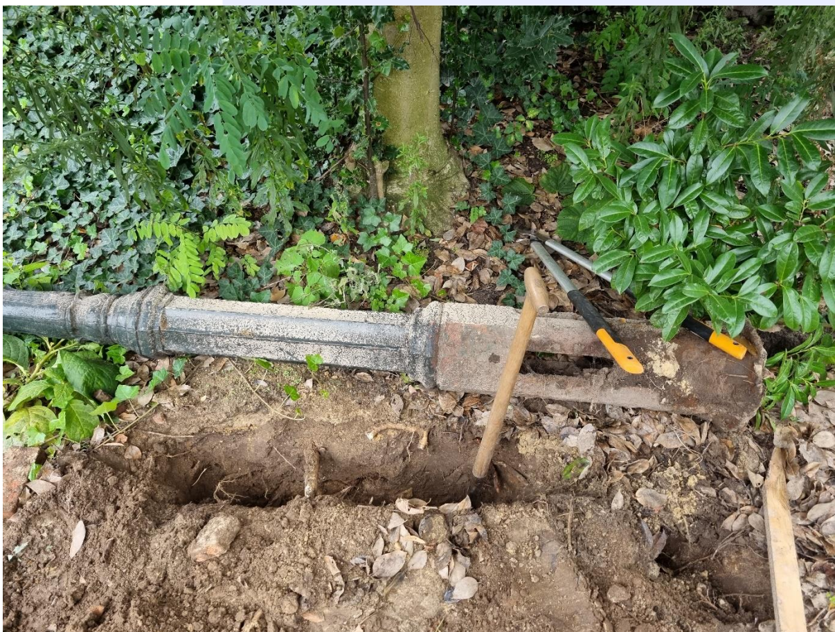
Foto 20: proefsleuf nabij boom 9
