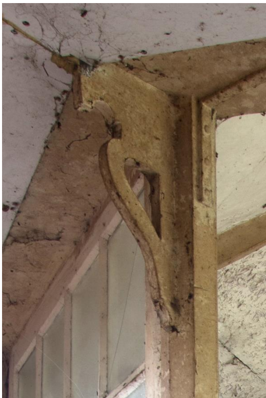
Detail van één van de consoles die wijzen op een bouwtijd tussen circa 1895 en 1915. In combinatie met perceel- en gebruiksgeschiedenis is een datering aan het einde van die periode het meest waarschijnlijk. Ook de vormgeving van het nokstijltje wijst op een vroeg twintigste-eeuwse oorsprong.
