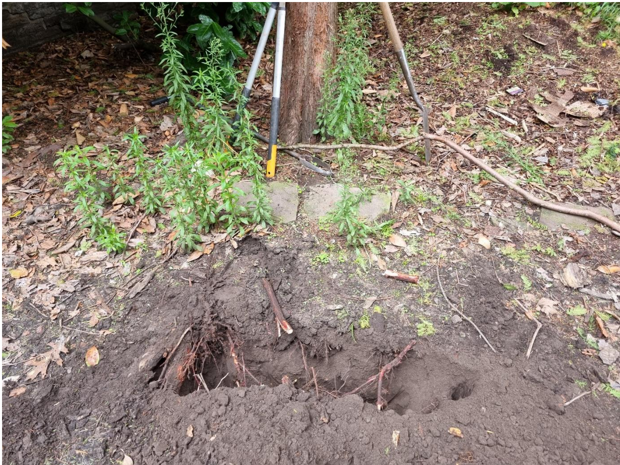
Foto 23: proefsleuf nabij boom 10
