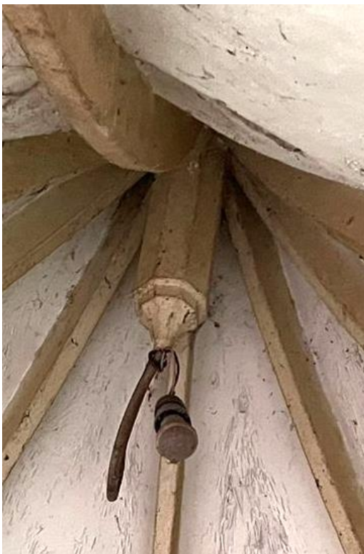
Detail van één van de consoles die wijzen op een bouwtijd tussen circa 1895 en 1915. In combinatie met perceel- en gebruiksgeschiedenis is een datering aan het einde van die periode het meest waarschijnlijk. Ook de vormgeving van het nokstijltje wijst op een vroeg twintigste-eeuwse oorsprong.
