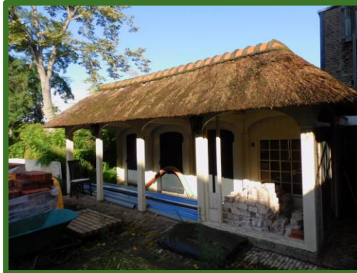
Bijgebouw (ten noorden van het erf)
