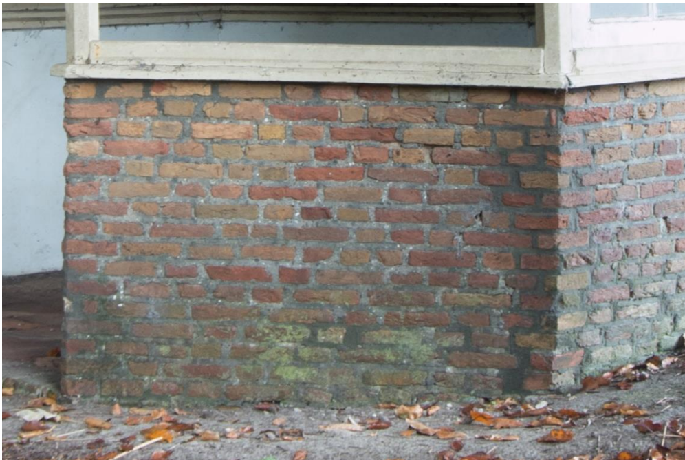
De gemetselde borstwering is van latere datum, zo kan onder andere worden opgemaakt uit vergelijking van het metselwerk met de tuingebouwen dichterbij het huis.
