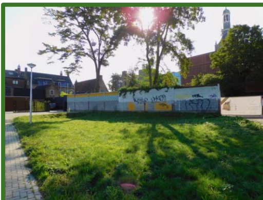
Muur ten noorden van de achtertuin
