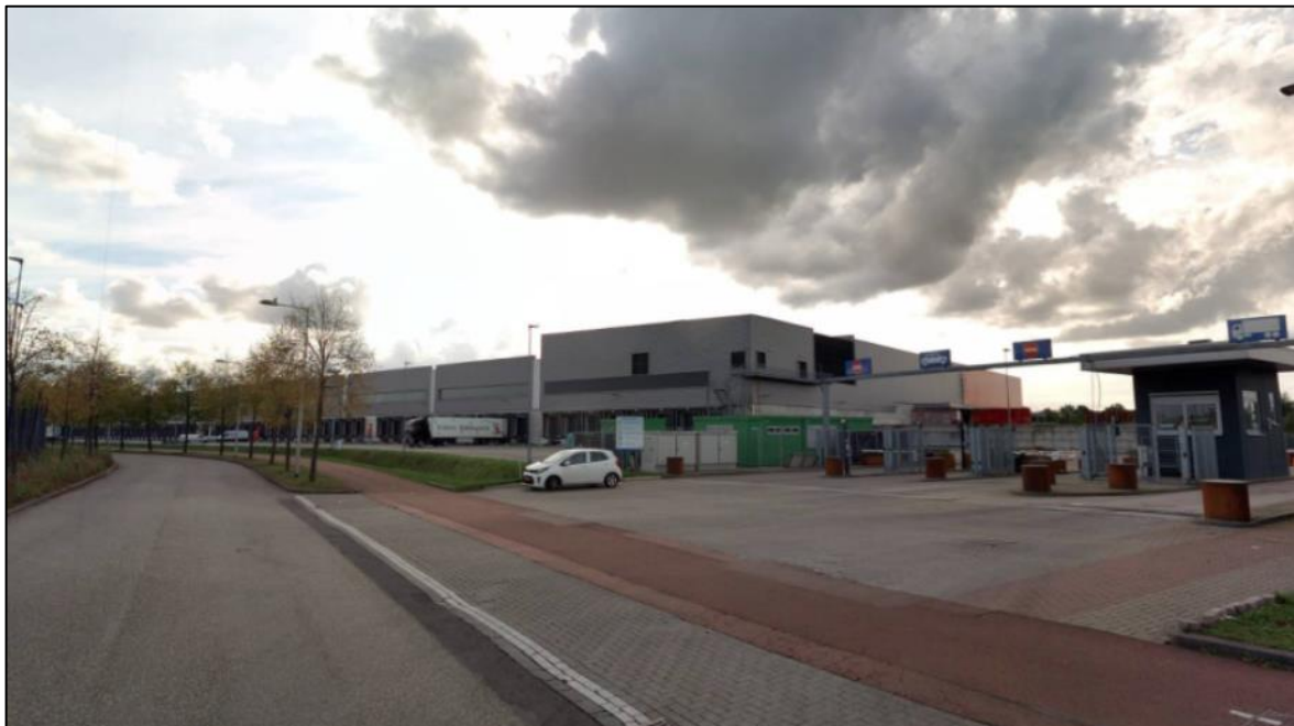
Aanzicht bestaande bouw vanaf het Zwarthoofd. Bron: © Cyclomedia Technology B.V., 2021.
