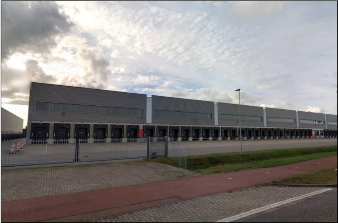
Aanzicht bestaande bouw vanaf het Zwarthoofd. Bron: © Cyclomedia Technology B.V., 2021.
