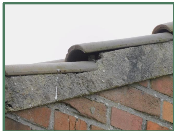
Ruimte onder dakpannen
