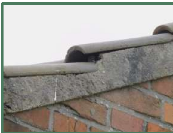
Ruimte onder dakpannen
