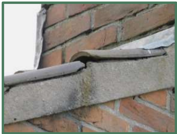
Ruimte onder dakpan
