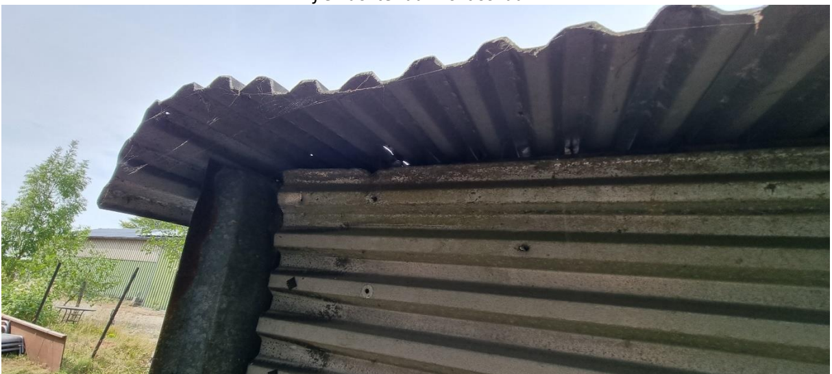
Dak achterzijde schuur
