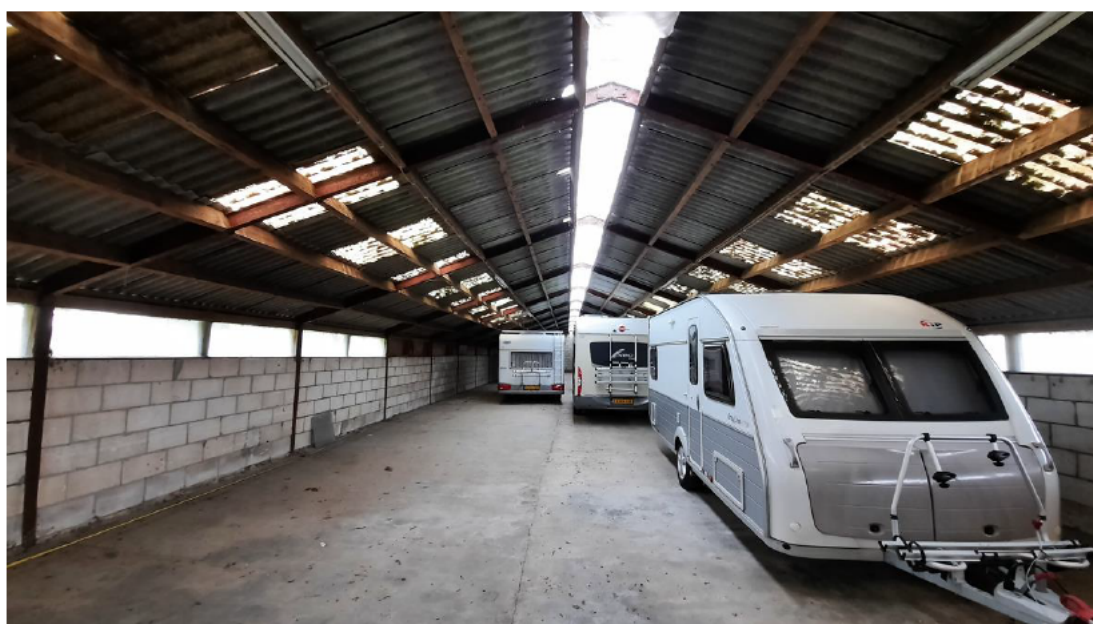
Binnenzijde voormalige kippenschuur. B. Verhoeven / Ecoresult B.V.
