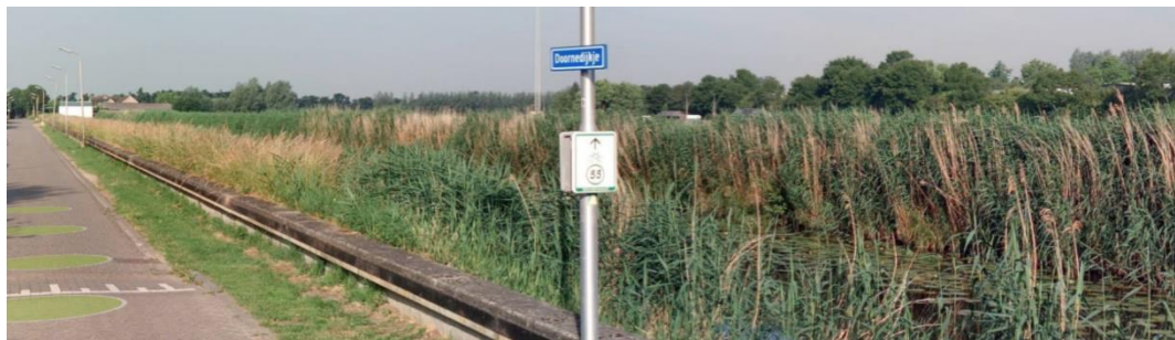
Figuur 4.2: Zicht vanuit Doornedijkje op te versterken dijklichaam
