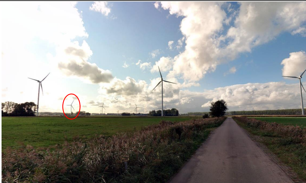
Figuur 19 Visualisatie vanuit kijkpunt 4 (ondergrens) van de Windturbine Hoge Zijpolder. Foto genomen vanaf Langeweg ten noordoosten van het windpark. Op de voorgrond is Windpark Zwartenbergseweg goed zichtbaar.
