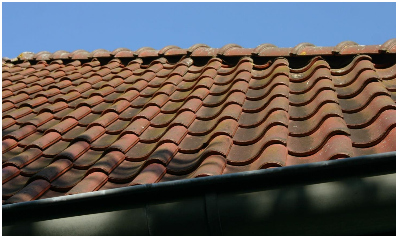
Figuur 4.4.2. Onder de ruimtes van de nokpannen is een doek aangebracht, dat de toegang tot het dak verspert.
