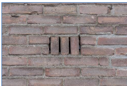
Figuur 06: luchtsleuven die toegang tot de spouw geven.
