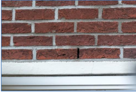
Figuur 08: stootvoegen die toegang tot de spouw geven.
