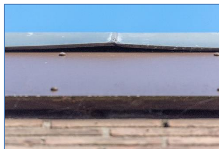
Figuur 05: opening tussen daktrim en boeiboord
