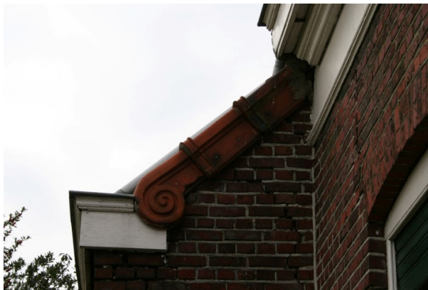
Detailopname van de gevel
