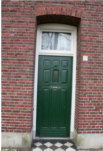
Portiek en voordeur
