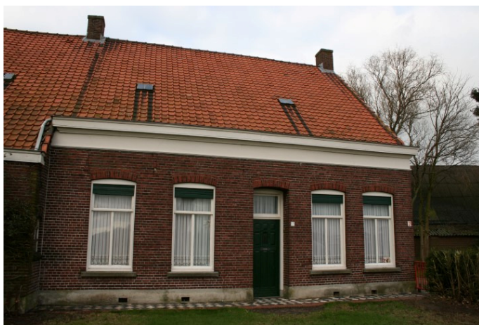
Voorgevel van het woongedeelte
