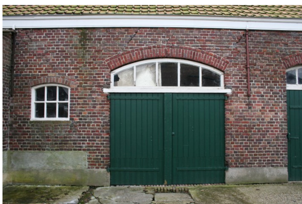
Dubbele staldeuren in achtergevel
