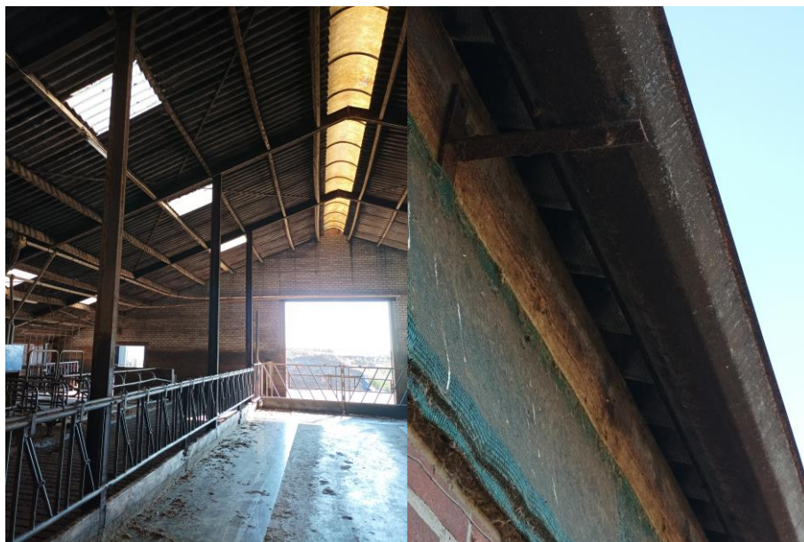
Figuur 4.4.1. De binnenkant van de stal met gevels zonder spouw en enkelvoudig dak.
