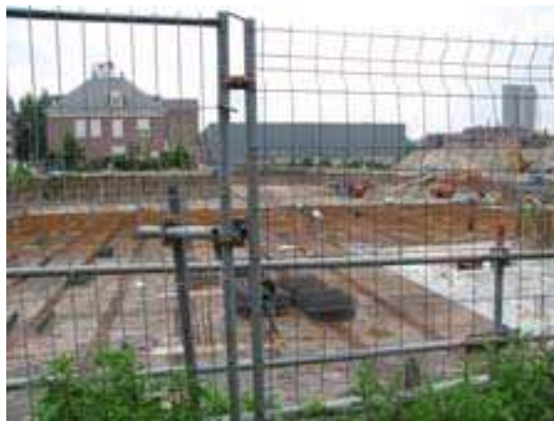
Bouwput Picus West
