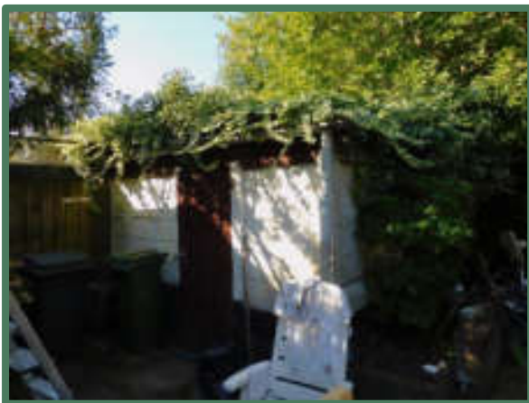
Schuurtje van betonelementen
