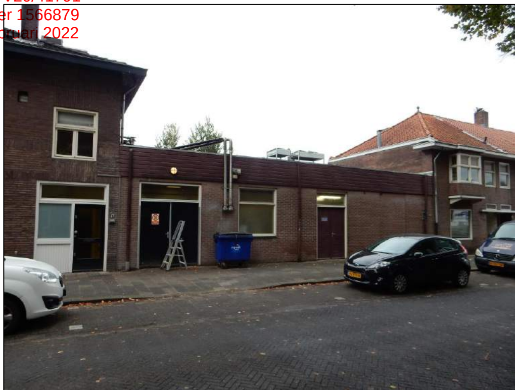
Figuur 1 De oostgevel van de te saneren bakkerij.
