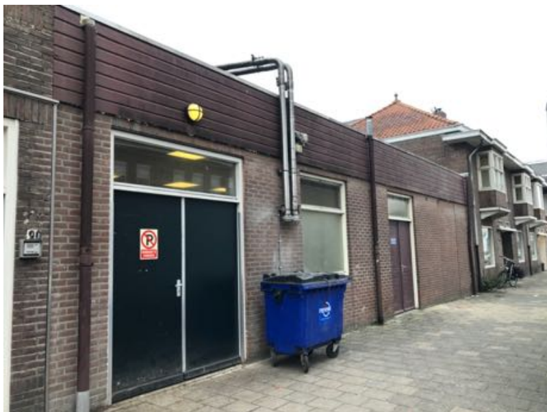
Afbeelding 1: Voorzijde van het te slopen deel. De boeidelen zijn hier duidelijk te zien.
