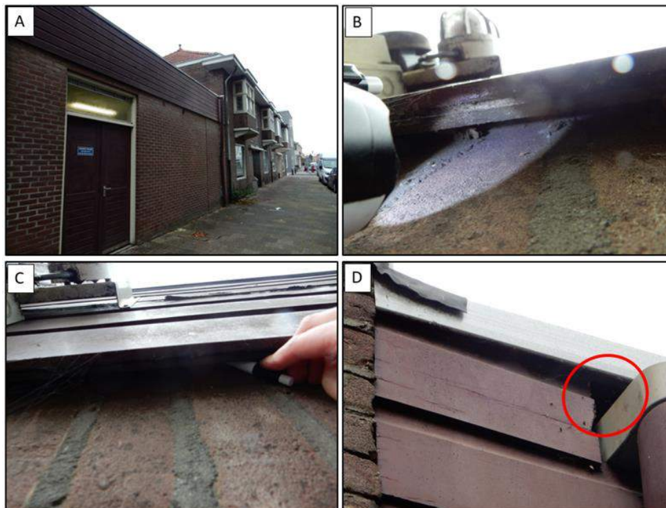
Figuur 4 Visuele representatie van de oostgevel van de bakkerij. (A) houten beplating is aanwezig op de gehele oostgevel. (B) er is een open ruimte aanwezig tussen de houten beplating en stenen muur. (C) de ruimte tussen de houten beplating en stenen muur is circa 1,2 cm (pendikte). (D) er is tevens een gat aanwezig boven een regenpijp waardoor de open ruimte achter de houten beplating bereikt kan worden.
