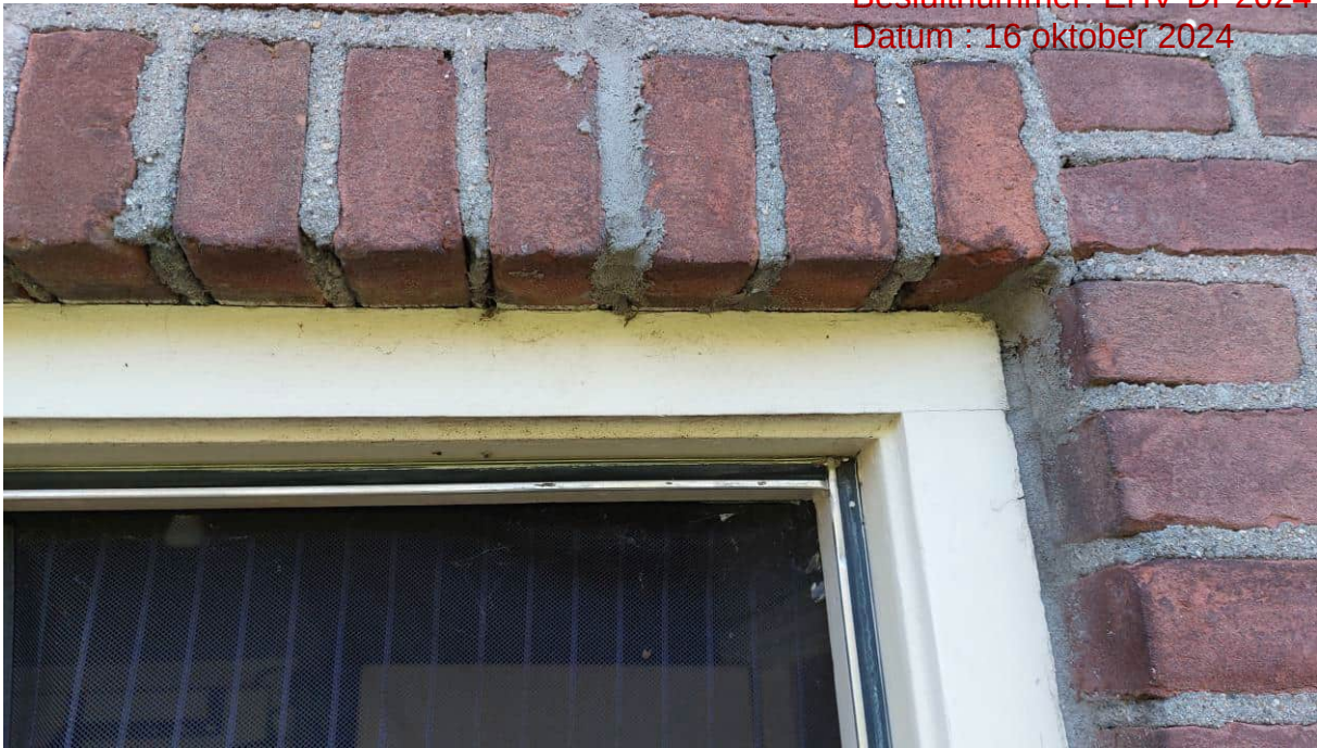
Figuur 4.4.4. Spleten of holten zijn afwezig in het gebouw.
