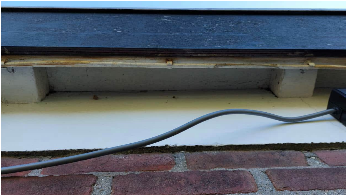
Figuur 4.4.2. Spleten of holten zijn afwezig in het gebouw.
