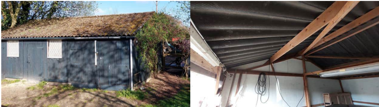
Figuur 4.4.1. De geheel enkelwandige schuur.
