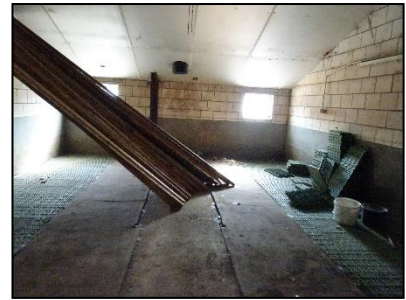
Figuur 11. Ruimte in de voormalige varkensstal.
