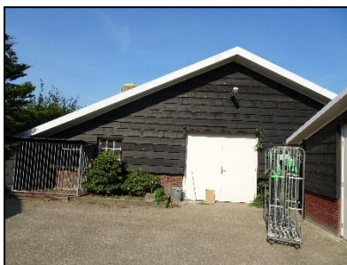
Figuur 3. Loods in gebruik als kippenstal, kijkrichting westen.
