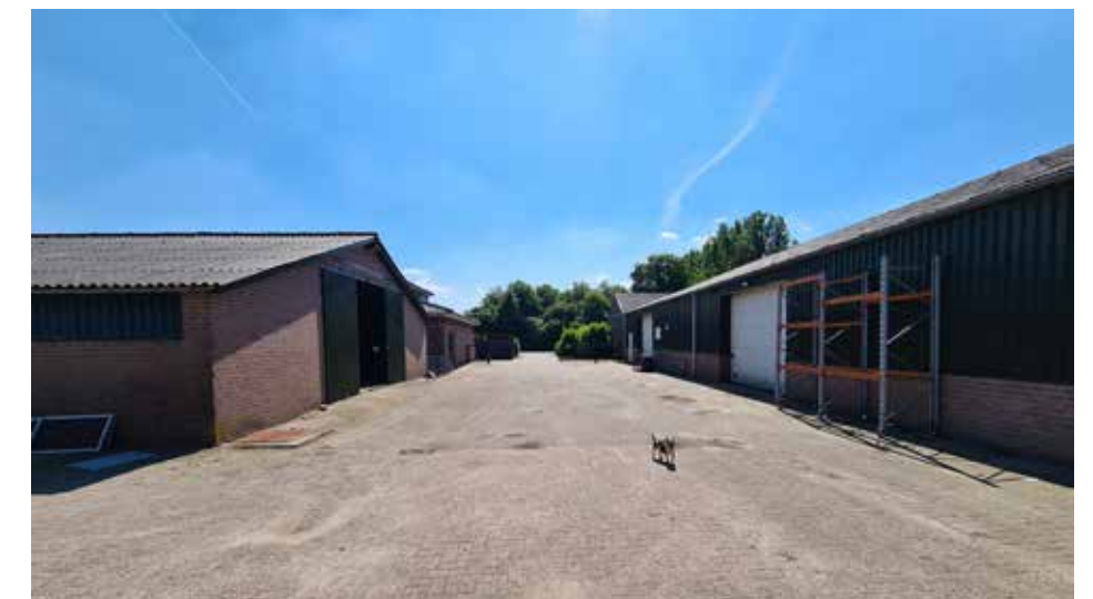
Links te saneren varkensstallen, rechts te behouden loods
