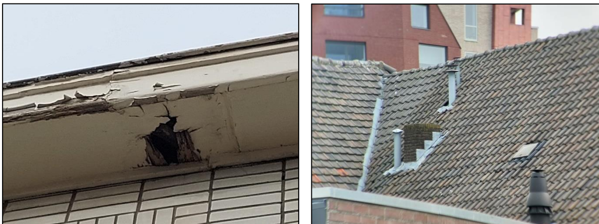
Figuur 5.3 en 5.4: mogelijke nestplaatsen van de huismus en gierzwaluw
