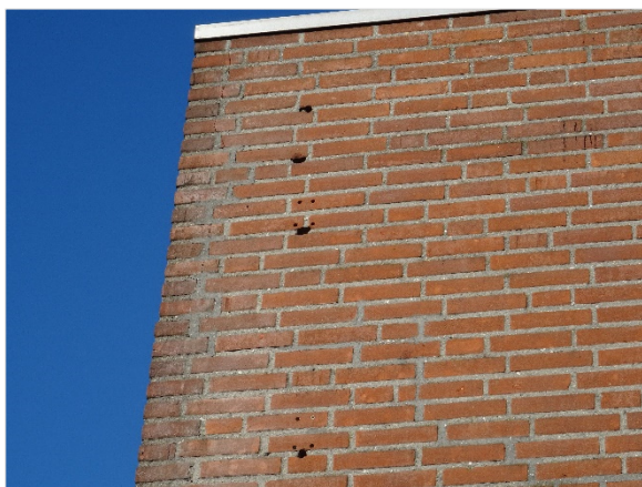
Figuur 5.1 Gaten die toegang verlenen tot de spouwmuur.
