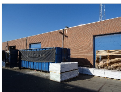
Figuur 2.7 Oostelijke zijde van noordelijke loods.
