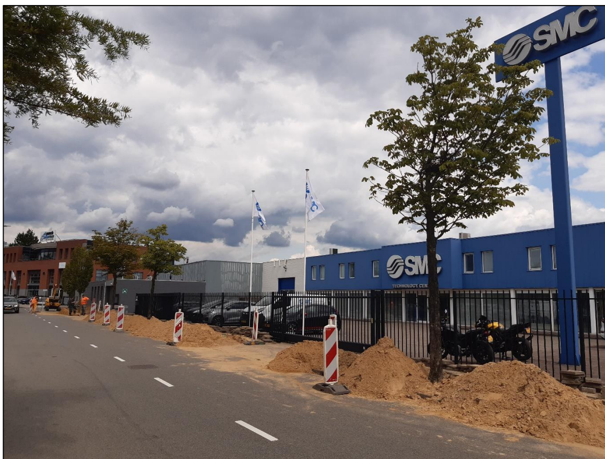
Afbeelding 10: Situatie ontgraving kabelsleuf bij boom 25.
