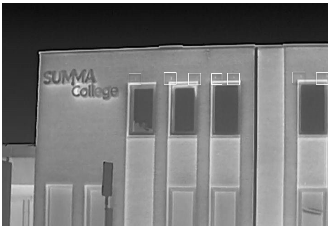
Figuur 9: Voorbeeld van nabij gelegen gebouwen met open stootvoegen.
