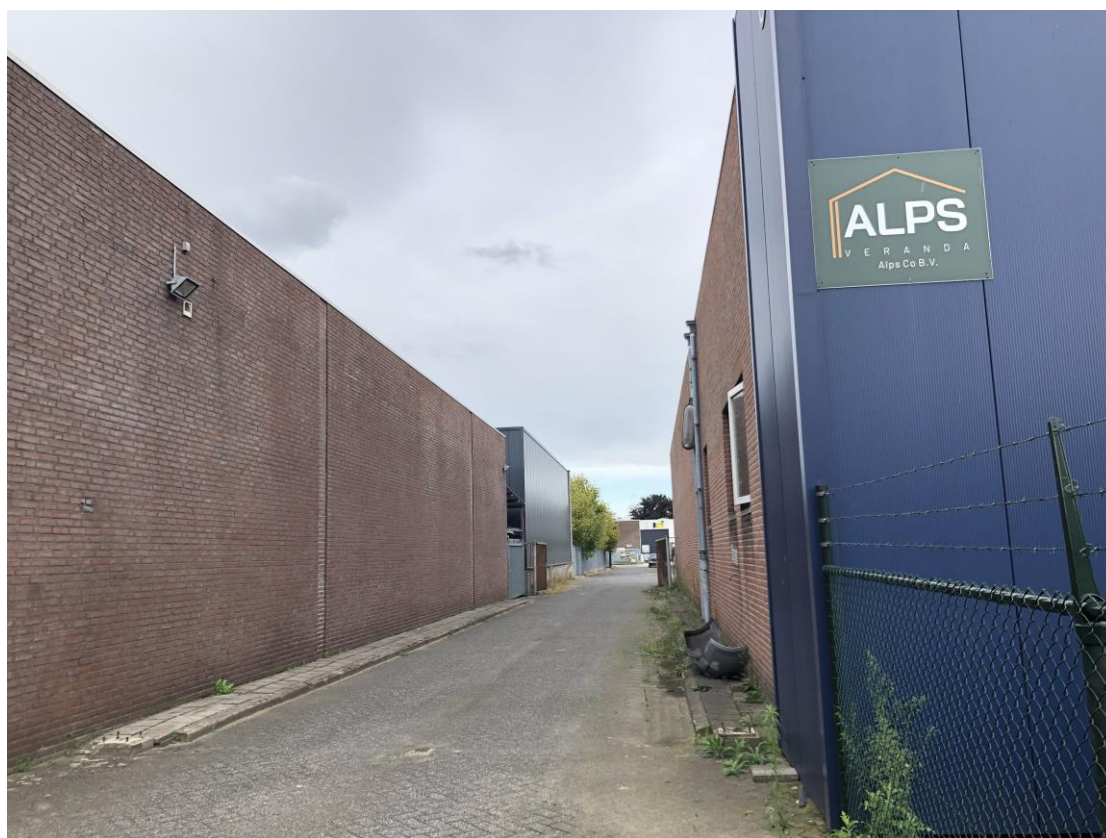
Figuur 4: Zicht op een doorgang van west naar oost. Rechter zijde betreft het voormalige VacanSoleil-pand.
