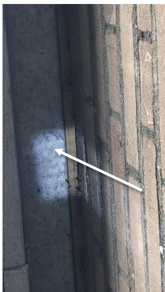
Figuur 5b: obstructie halve spouwmuur.
